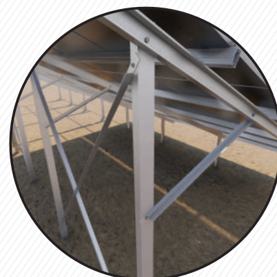
C Profil &amp; Winkelhalterverbindung
